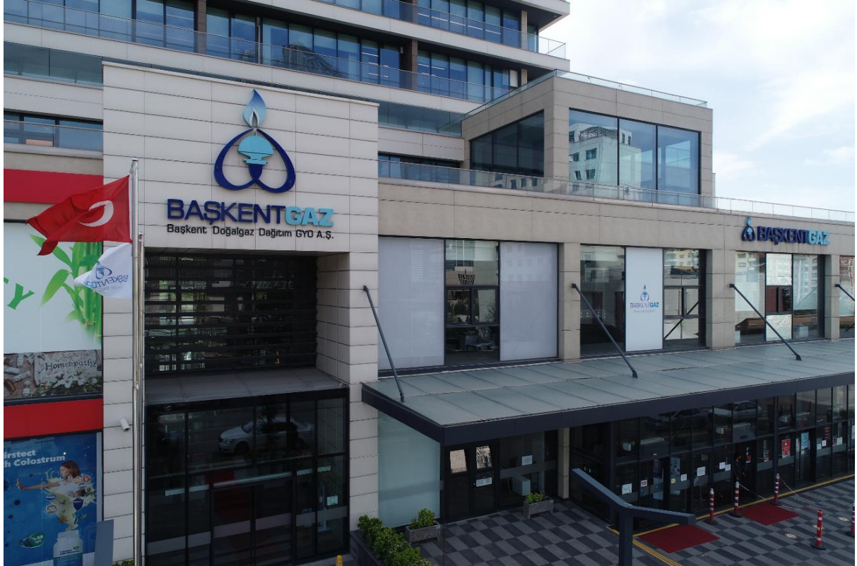
Şekil 35: Başkentgaz Merkez Binası - 1
